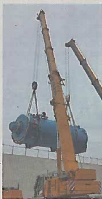
Il a fallu deux puissantes grues pour installer le four.
